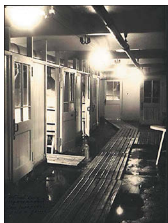
▲ Внутренний вид прачечной 162-квартирного дома
