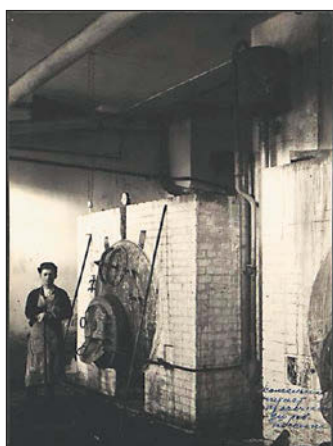
▲ Источник в котельной прачечной
