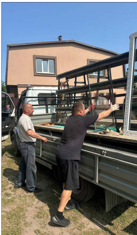
▲ Новые окна — вместо поврежденных.
