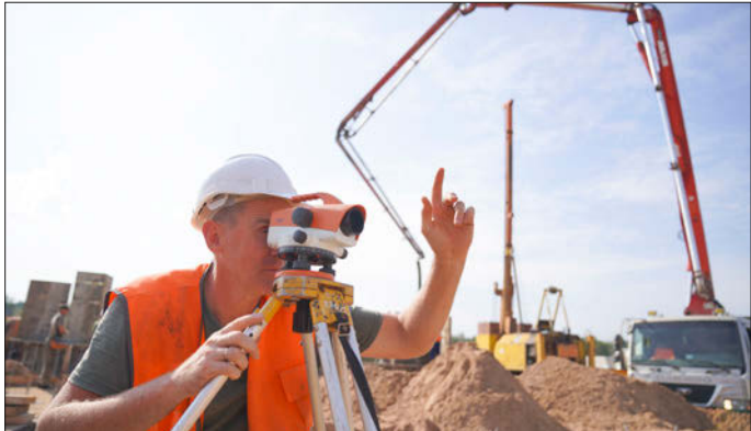
▲ На строительстве станции водоподготовки «Водоканала»
