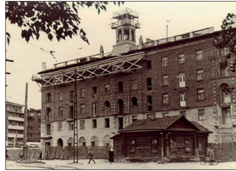
▲ Строительство жилого дома ИвТЭЦ (ул. Мархлевского, д. 34/45) по проекту Н.Ф. Менде 1950-е
