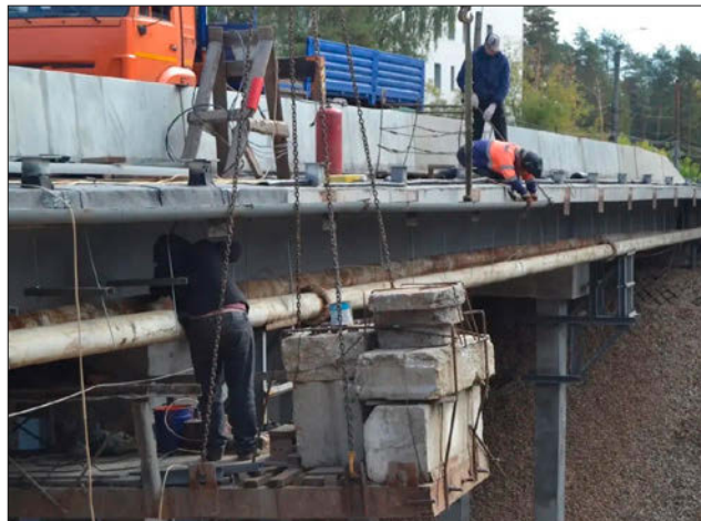
▲ Ремонт путепровода на ул. Смольной
