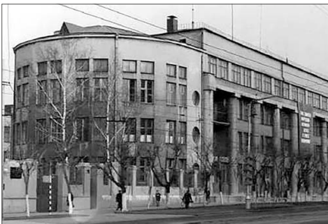
▲ С 1933 года ивановское управление НКВД располагалось в новом здании на пр. Ленина. В «доме-пуле» (второе название – «серый дом») проводились следственные действия в период Большого террора. После пожара 2008 года здание не используется и, судя по всему, не подлежит восстановлению.
